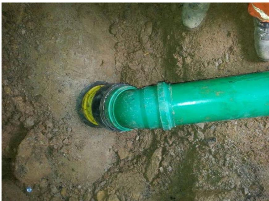
Abb. 5.2: Anschluss einer Anschlussleitung am öffentlichen Hauptkanal
