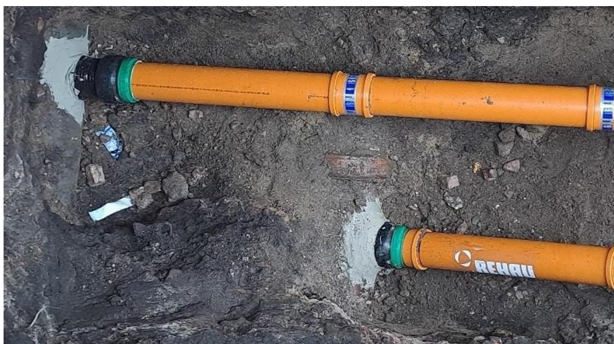
Abb. 4.2: Einbindung von Anschlussleitungen an öffentliche Hauptkanäle
